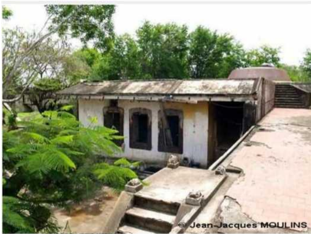
Ouvrage de Rach-Cat Massif de la tourelle A Mai 2008
