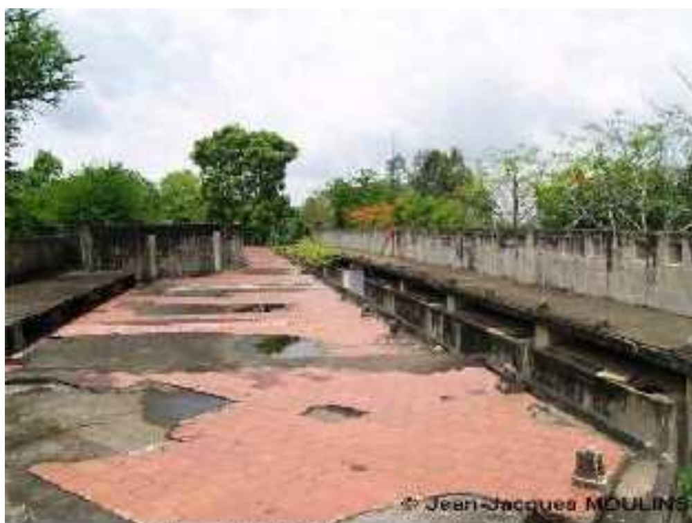
Ouvrage de Rach-Cat Tranchée de évacuation et aération de l'eau de charge Mai 2008
