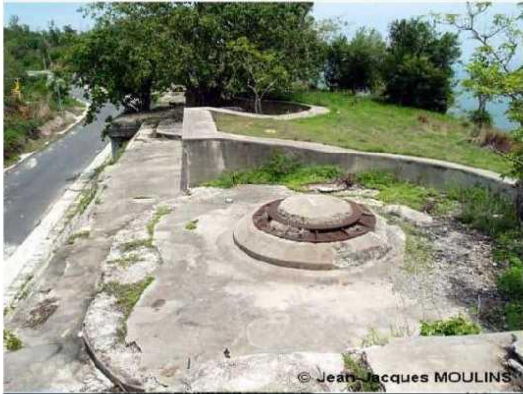
Batterie de la Position N°1 Mai 2009
