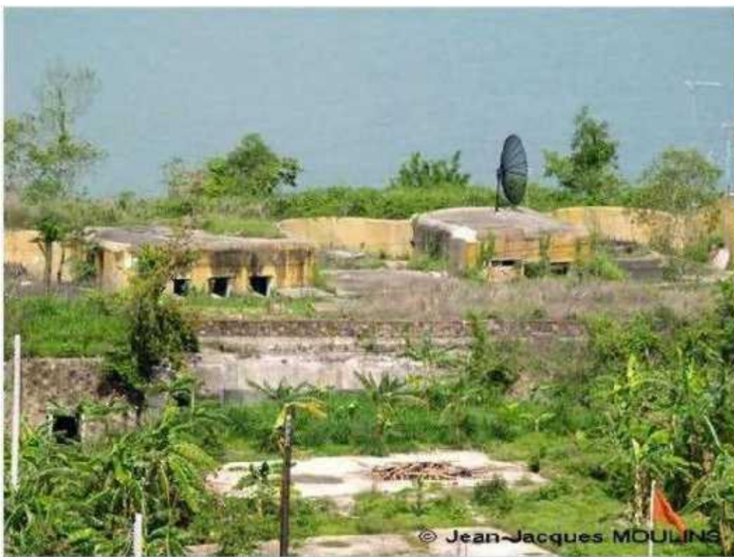
Batterie de Droite du Grand Eperon Mai 2008
