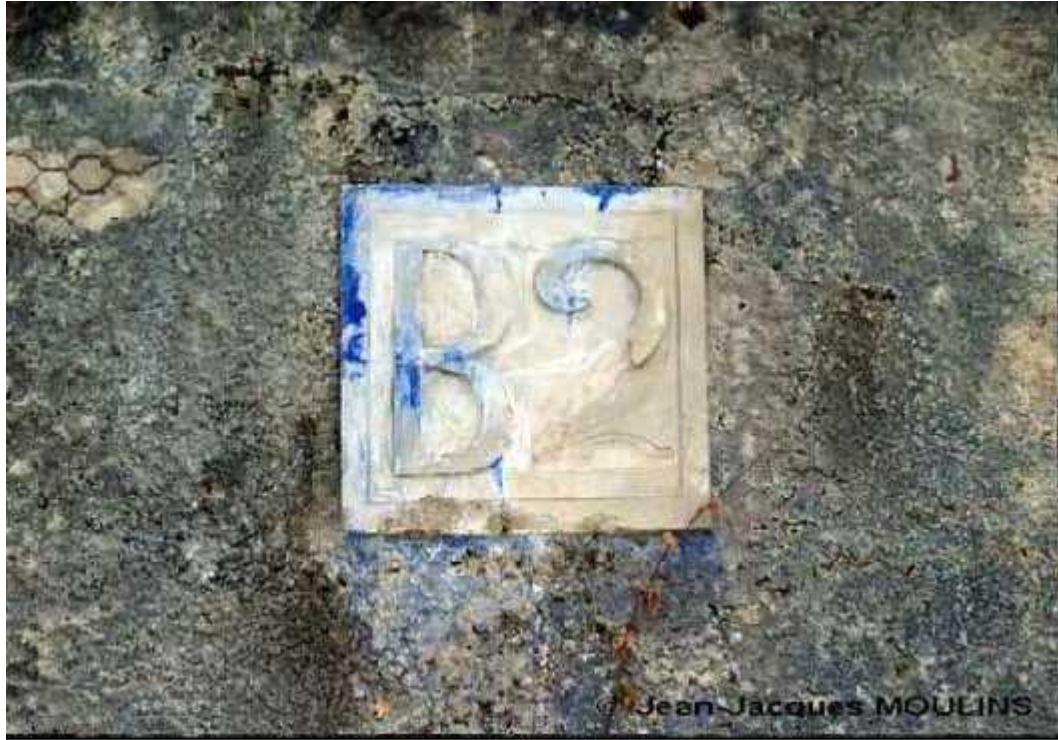
Batterie de la Position N°1 Mai 2008
