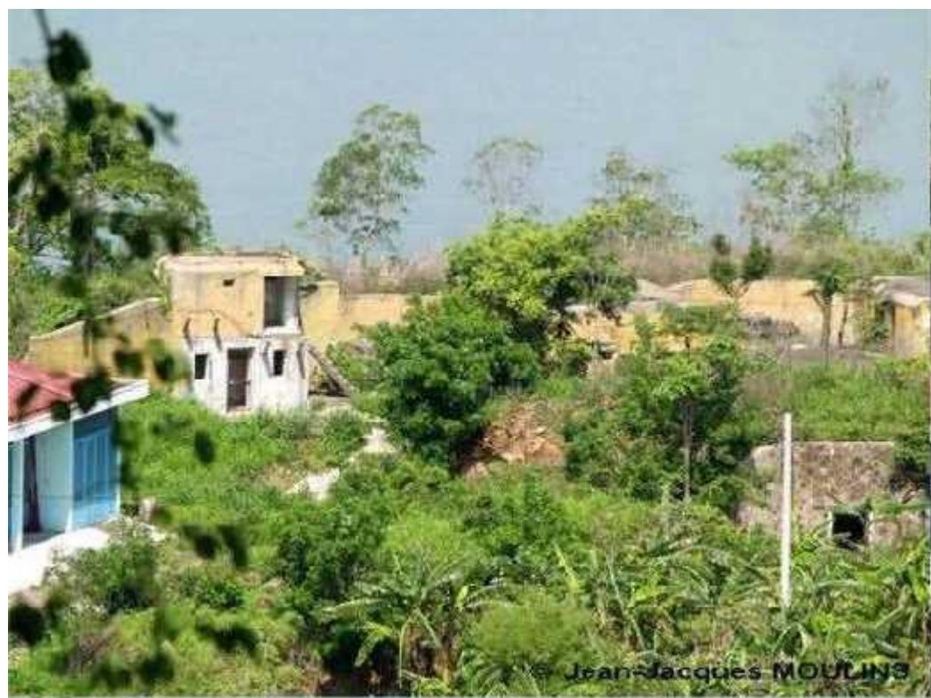
Batterie de Droite du Grand Eperon Mai 2008
