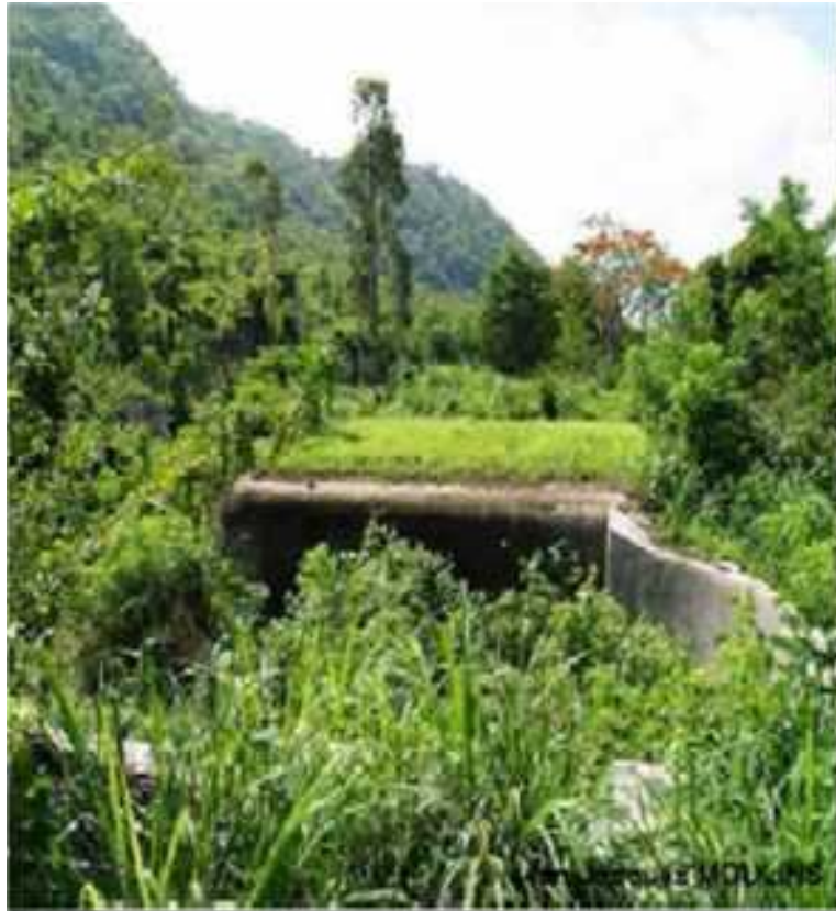
Batterie de Savoie de Ouziers - Juin 2018
