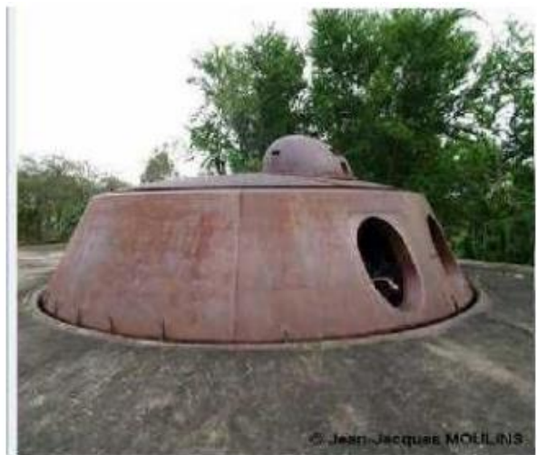
Ouvrage de Fach-Cat Barrele A M4 2008
