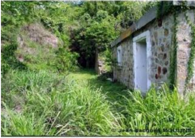
Batterie du Cable Nelson du gardien et entrée du magasin Mai 2008
