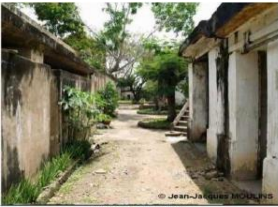
Ouvrage de Fach-Cat Caserne Mai 2008
