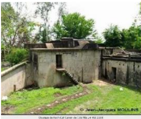
Ouvrage de Rach-Cat Canon de 138 Pts 24 M 2108
