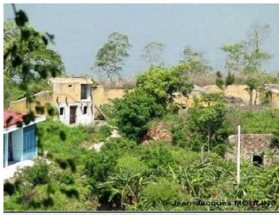
Batterie de Droite du Grand Eperon Mai 2008
