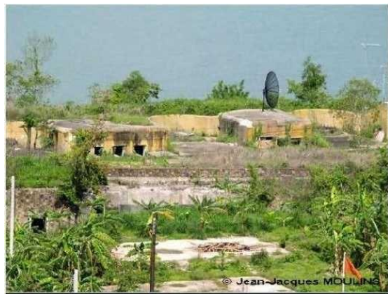
Batterie de Droite du Grand Eperon Mai 2008
