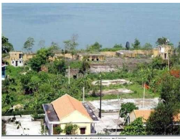
Batterie de Droite du Grand Eperon Mai 2008
